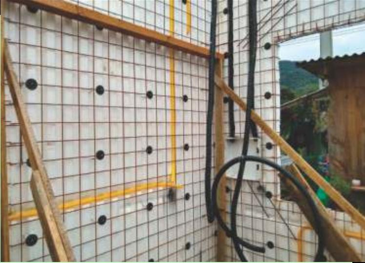
O painel em EPS tem um corte na posição vertical que permite a passagem de conduítes e tubulação de até 3/4 de polegada, assim, o primeiro passo é desenhar os percursos das instalações e proceder com a passagem, sendo certo que esse procedimento proporciona um processo mais ágil e eficaz na execução do projeto, já que não há a necessidade quebrar a alvenaria como no método tradicional.
